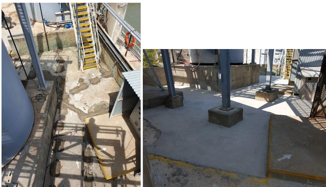
Figure 3 : Dalle ragréage béton (19/07/2021)
