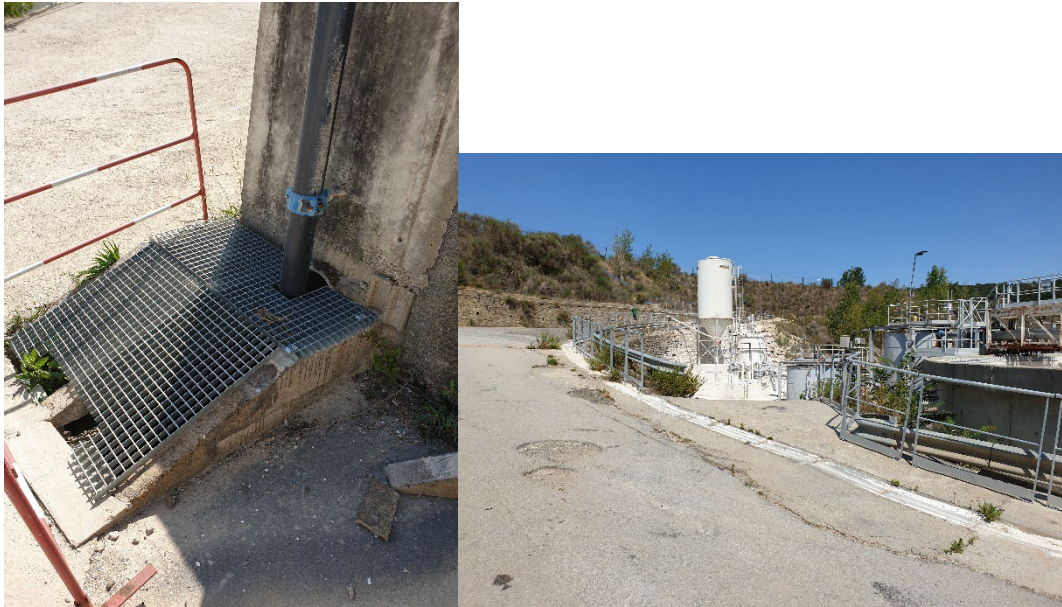
Figure 4 : Installation de garde-corps, sécurisation vis-à-vis du risque de chute de hauteur
